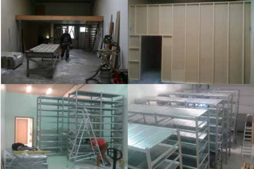
Skjalageymsla Héraðsskjalasafnsins að Háheiði á ýmsum stigum innréttinga og breytinga sem gerðar voru á húsnæðinu. Reikna má með því að geymslan taki um 500 hillumetra af skjölum sem samsvarar u.þ.b. því magni skjala sem safnið tekur á móti næstu 10 ár.
